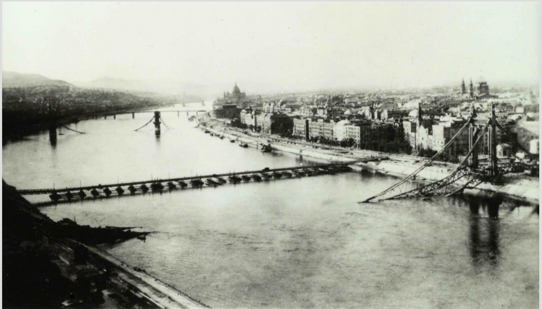
1945. november 18 – elkészül a Petőfi pontonhíd
