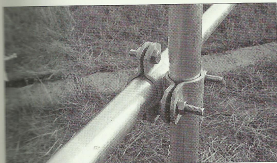
Bild 5: Die Verbindung Mast/Boom erfolgt mit einer geschweißten Kreuzschelle
